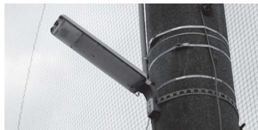
▲LED化された防犯灯
